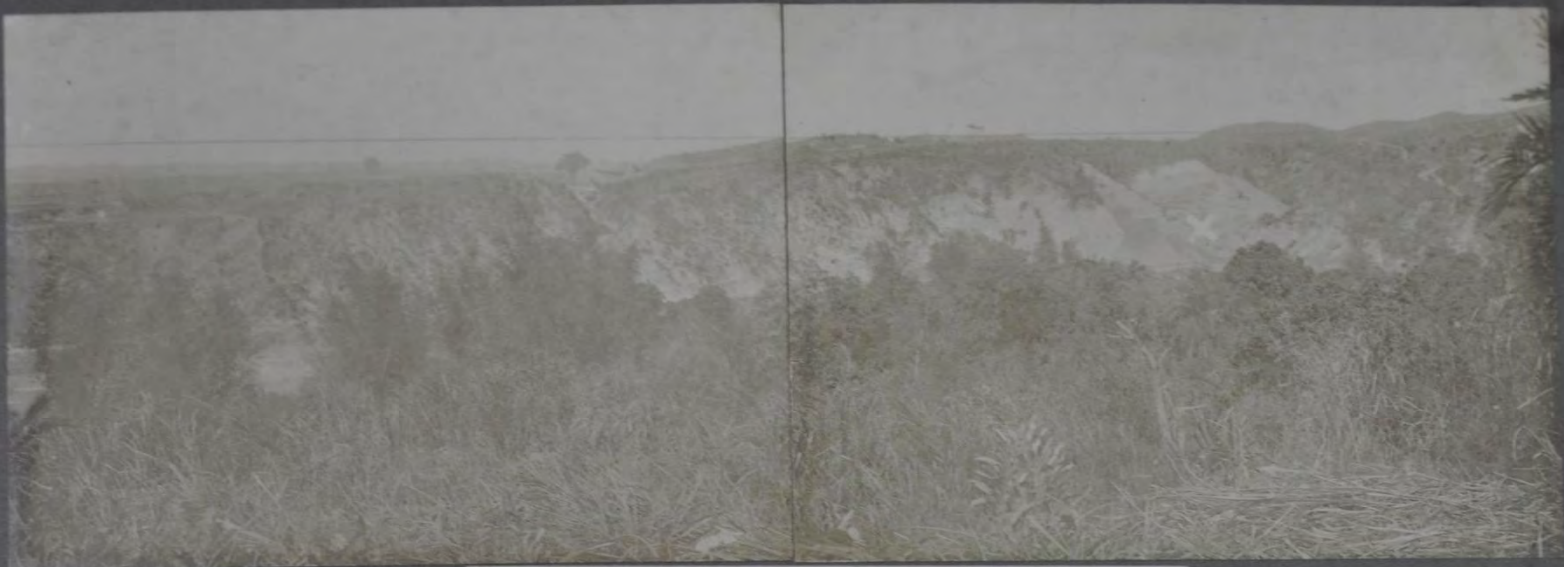
内面ヨリ見タル堰堤ノ位置 ×印ハ排水路出入口 一線ハ完成後ノ堰堤傾部ヲ示ス 大正十一年二月二十二日
