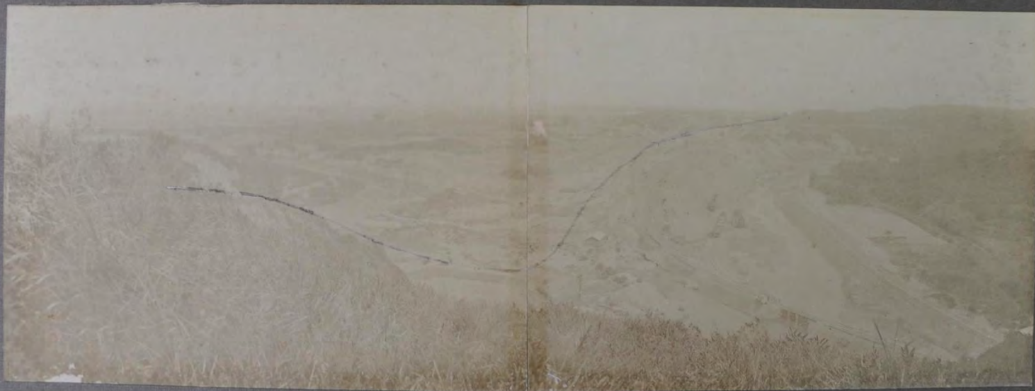
南方高地ヨリ俯瞰シタル堰堤位置 大正十三年三月八日 (自 録・中ノ史ヲ示)
