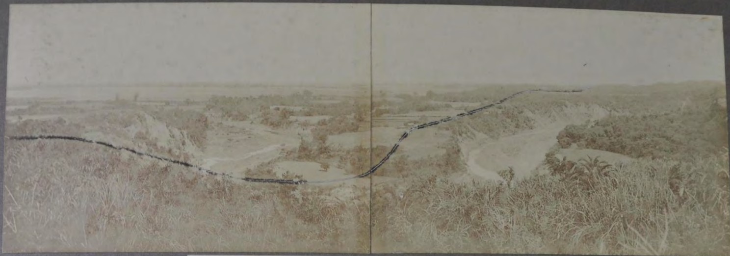
南方高地ヨリ見たル堰堤位置 (大正十年六月工事着手前 白線ハ中心点ヲ示ス)
