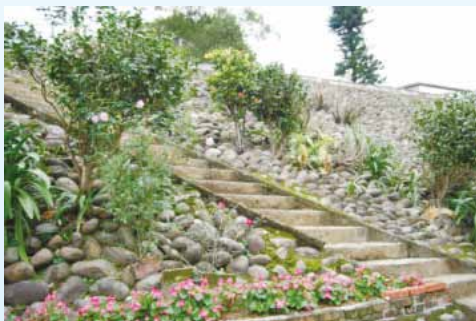
圖 3-9 平溪線平溪站平溪鐵橋旁路堤型路基
