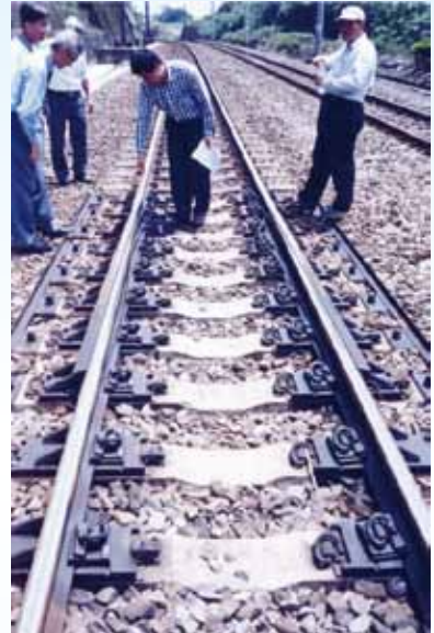
圖 3-3 預力混凝土枕道碴道床
