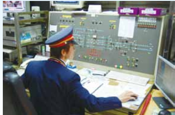
圖 6-3 台鐵瑞芳站中央控制行車系統中的車站設備
