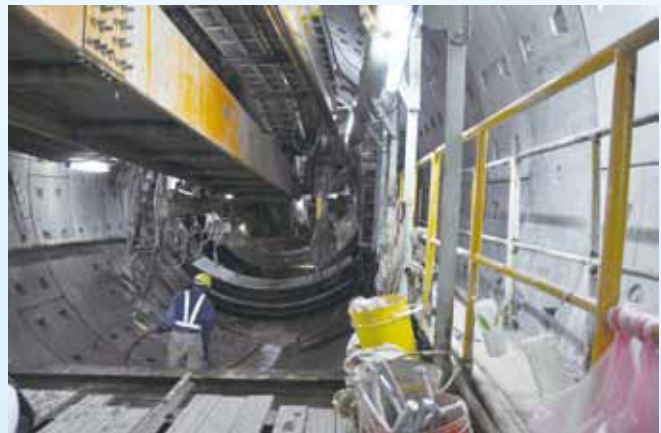
圖 4-3 機場捷運系統第三航廈站鄰接隧道運用潛盾工法
