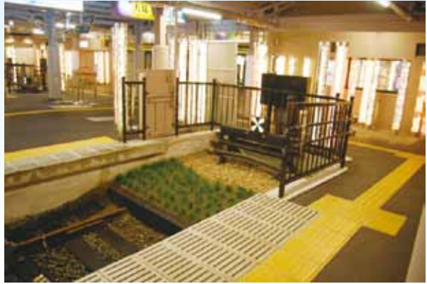
圖 3-11 日本京都嵐山線終點站嵐山站的止衝檔，配合景點亮點設計增加綠化設計
