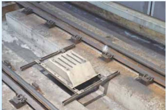
圖 3-7 基扳構造（台北捷運安裝的基扳）
