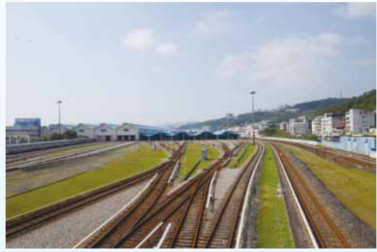
圖 7-3 台北捷運北投機場為單側式調車場（右線軌道為主線軌道）
