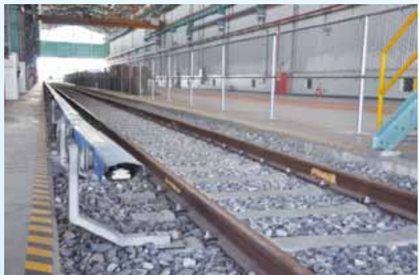
圖 5-3 高雄捷運電聯車第三軌
