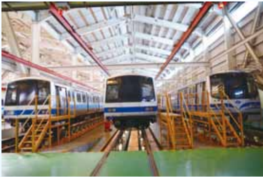
圖 7-2 北投機廠主維修工廠頂升區與正維修車輛
