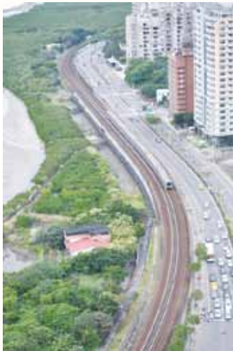
圖 2-1 圓曲線 (Curve) 台北捷運淡水線紅樹林站出站往淡水站方向路線
