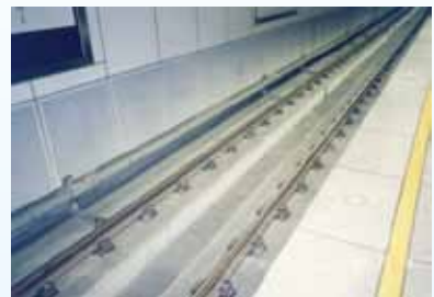
圖 3-4 連續基座式混凝土道床（台北捷運）
