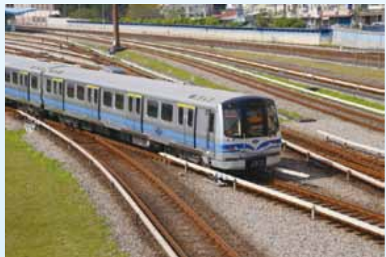
圖 3-2 木枕道碴道床（台北捷運北投機廠道岔區）
