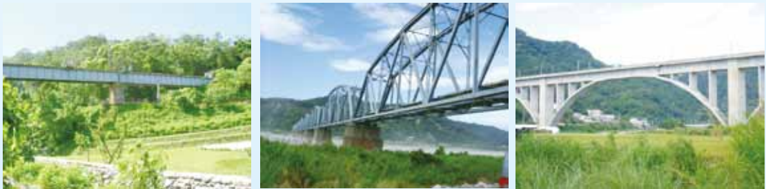
圖 4-4 (左) 鈹梁橋—新魚藤坪橋 (完成於 1938 年) (中) 桁架橋 (Truss Bridge) 橋—大安溪鐵橋 (完成於 1906 年) (右) 拱橋—鯉魚潭橋 (1988 年)
