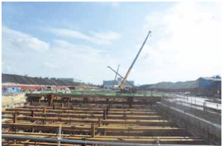
圖 4-2 機場捷運系統第三航廈站（明挖覆蓋工法）
