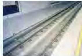
圖 3-4 連續基座式混凝土道床 (台北捷運)
