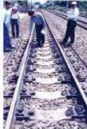
圖 3-3 預力混凝土枕道床
