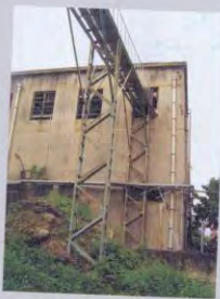
舊台中酒廠架高兩層樓高的輸米管。
