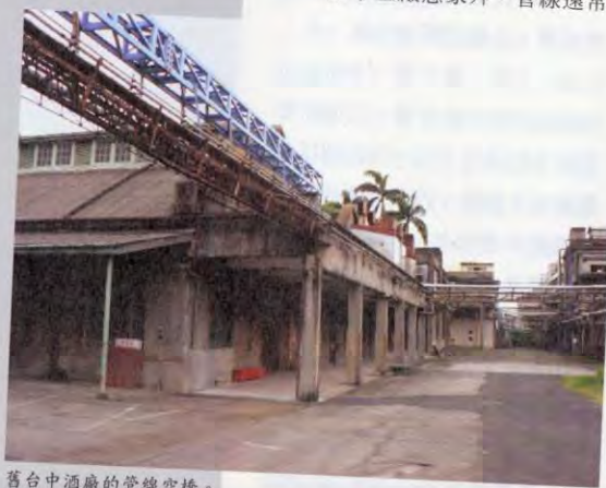
舊台中酒廠的管線空橋。
