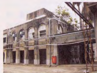
舊台中酒廠處處管線。
