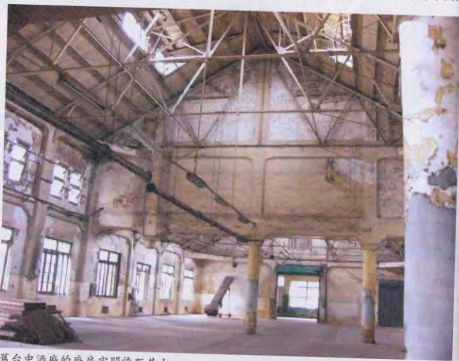
舊台中酒廠的廠房空間跨距甚大。
