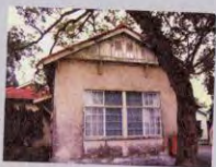
日式宿舍大開窗及通氣窗以促進熱循環。圖為斗六糖廠招待所。
