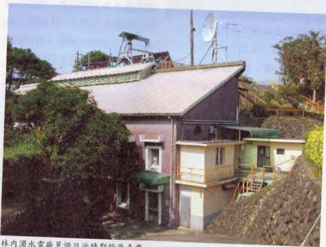
林內濁水電廠見證日治時期能源產業。
