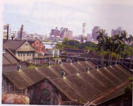
通風設施是舊台中酒廠的重要設施與景觀。
