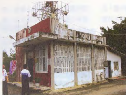
飛沙派出所的格狀輪體，體現了抵擋風沙與烈陽的地方智慧。
