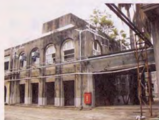
舊台中酒廠處處管線。
