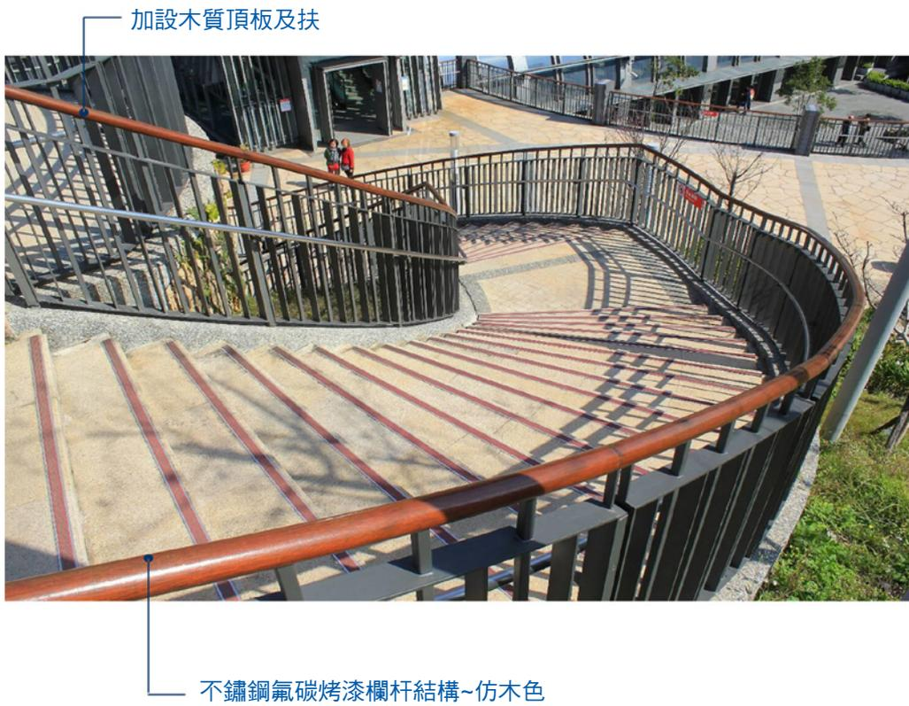
圖14 弧形螺旋階梯欄杆
