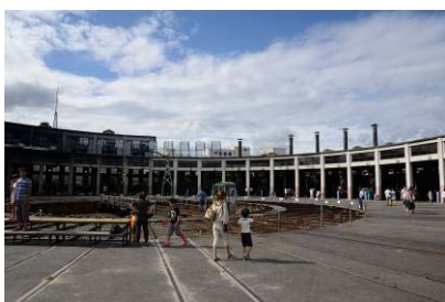
圖 29 梅小路機關車館扇形車庫〔建築〕
