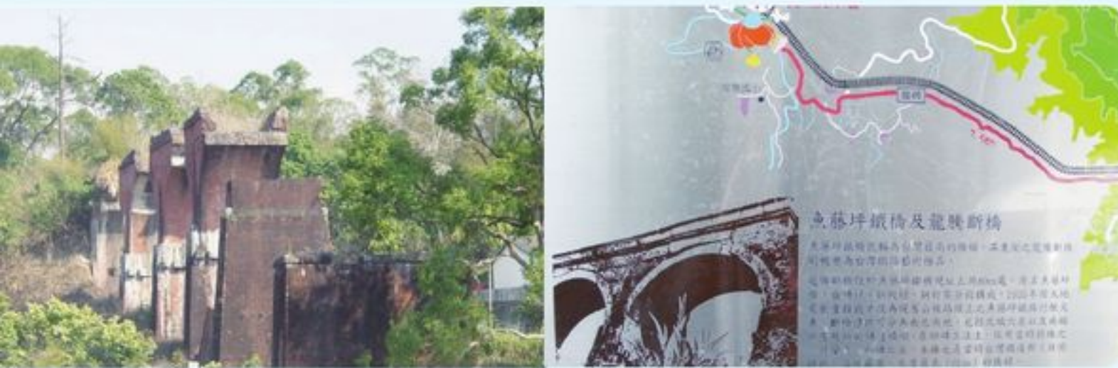
圖 4.7.2-1 魚藤坪斷橋遺蹟（現名「龍騰斷橋」）
