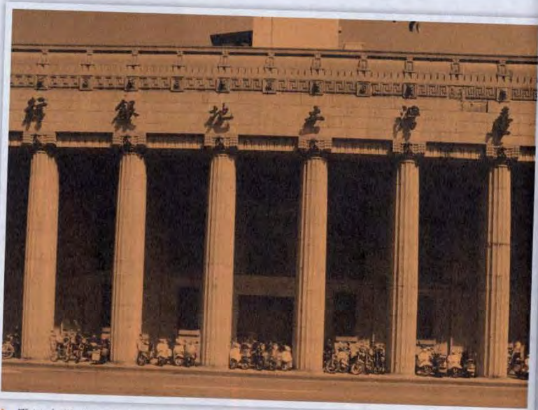
▲ 原日本勸業銀行台北支店正立面。
