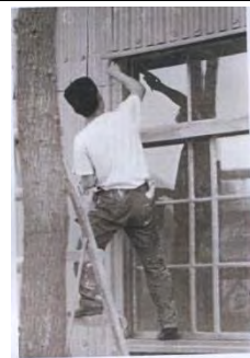
圖 28 大壩處工人修築宿舍，照片提供
