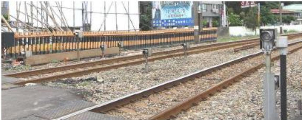
圖7.5 障礙物偵測器設置現況
