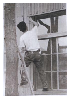
圖 28 大壩處工人修築宿舍，照片提供
