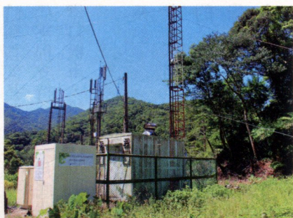
燃料電池已應用在偏遠山區，作為大哥大基地台的備用電力，並可使用電信線路遠端監控電力狀況。 (圖為坪林碧湖基地台)
